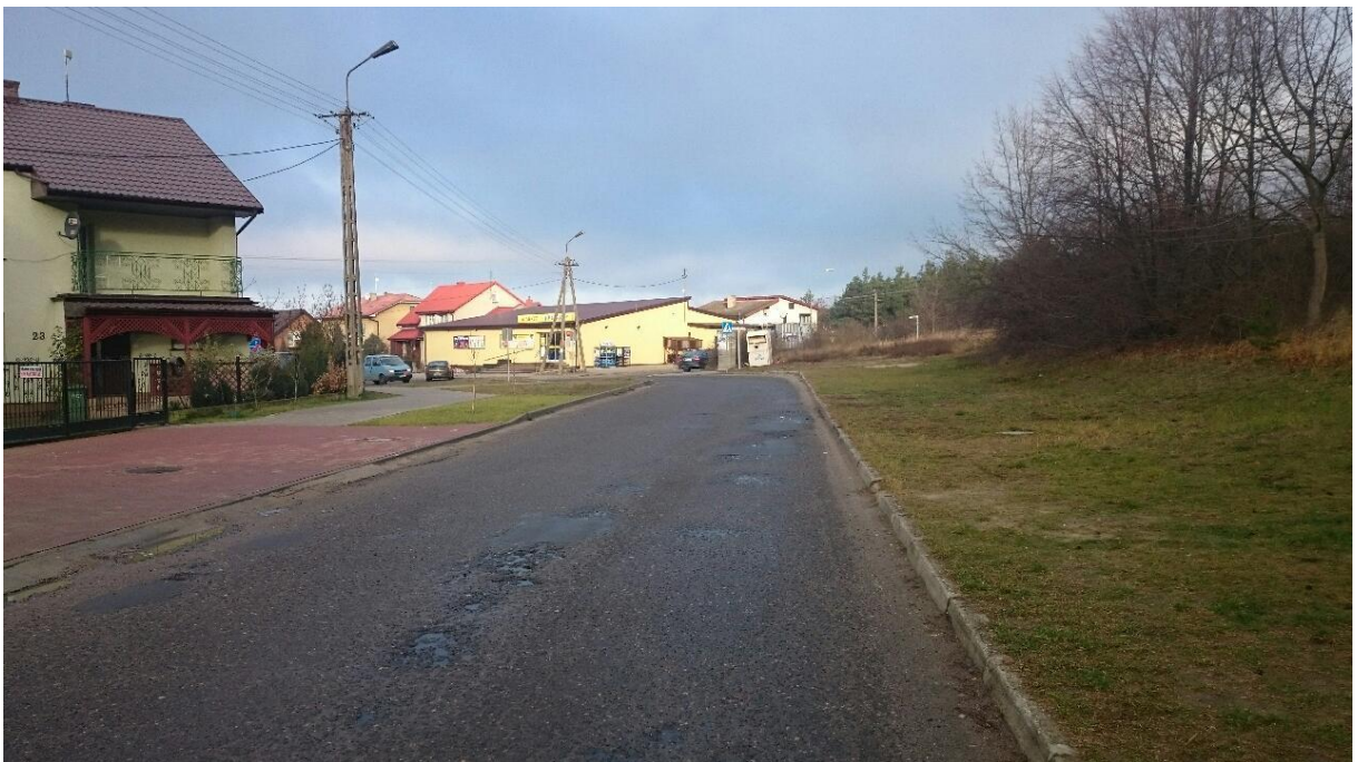
zdjęcia nr 2 - istniejący krawężnik betonowy po prawej stronie przewidziany do wymiany
