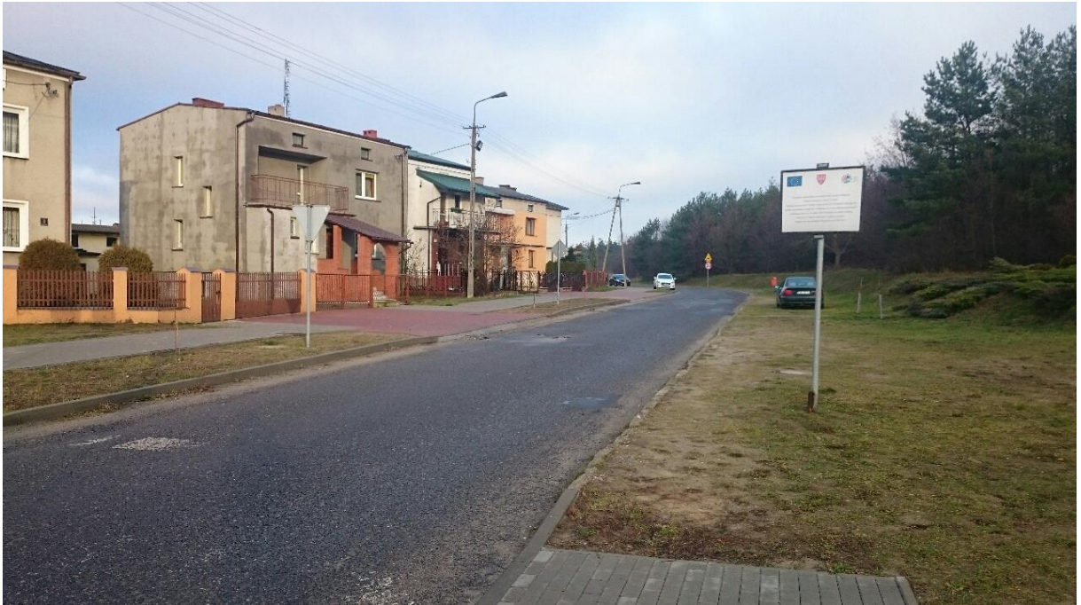
zdjęcie nr 1 początek opracowania , projektowana budowa chodnika z kostki brukowej( strona prawa)
