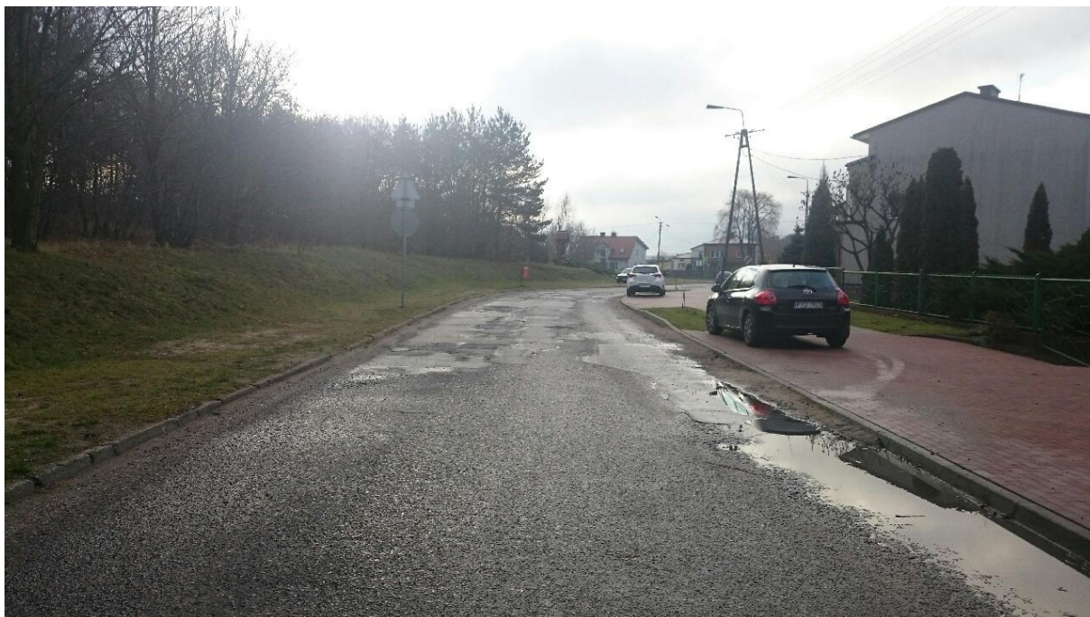
zdjęcie nr 3 nawierzchnia istniejąca przewidziana do frezowania
